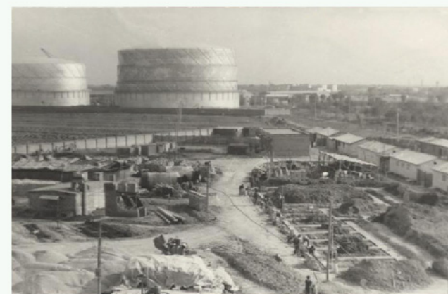
建所初期施工场景
